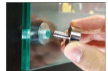
3. パッキンを取り付けサインナット頭部をねじ込み施工完了。
